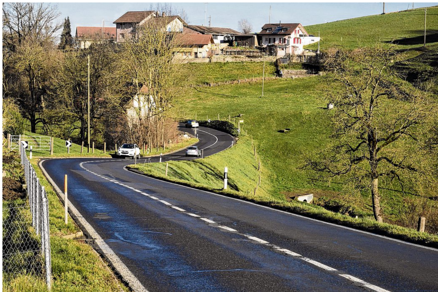
Eines der Projekte, mit denen sich auch der zukünftige Gemeinderat von Böisingen auseinandersetzen wird, ist die geplante Sanierung der Kantonsstrasse durch Riederberg.
